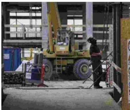
Un operaio edile durante i lavori in cantiere
